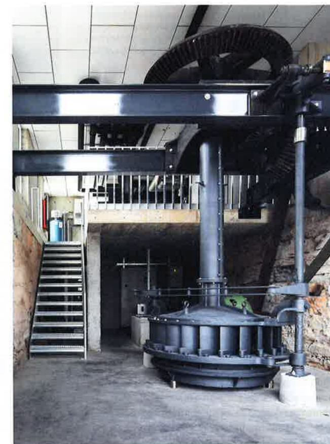
In einem Technikraum steht als Museumsstück die fachgerecht restaurierte Kraftwerksanlage mit Francis-Turbine und Kammrad aus Holz- und Stahlzähnen.
